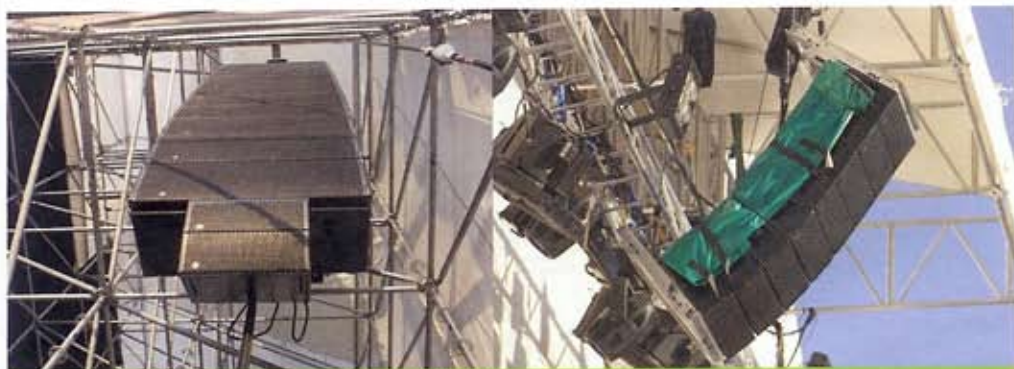
Il PA Adamson all'Arena: cluster laterale, cluster centrale e sub.
